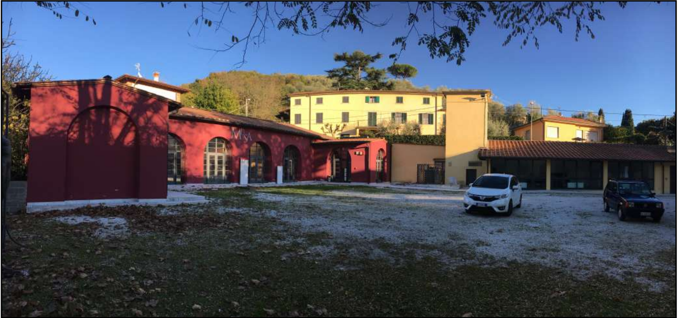
FOTO 1 - VISTA DEL COMPLESSO
